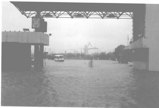
风暴潮造成塘沽区进水
