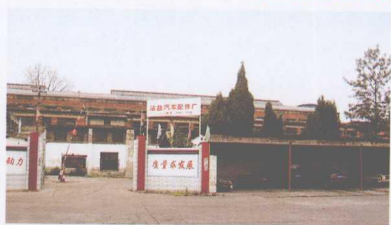
云南曲靖交通集团公司钢结构施工处(配件厂)
