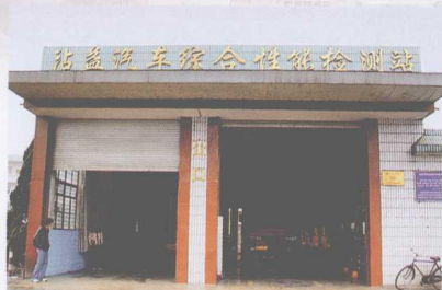
沾益汽车综合性能检测站
