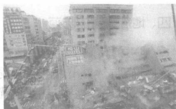
台湾 922 地震中坍塌的楼宇
