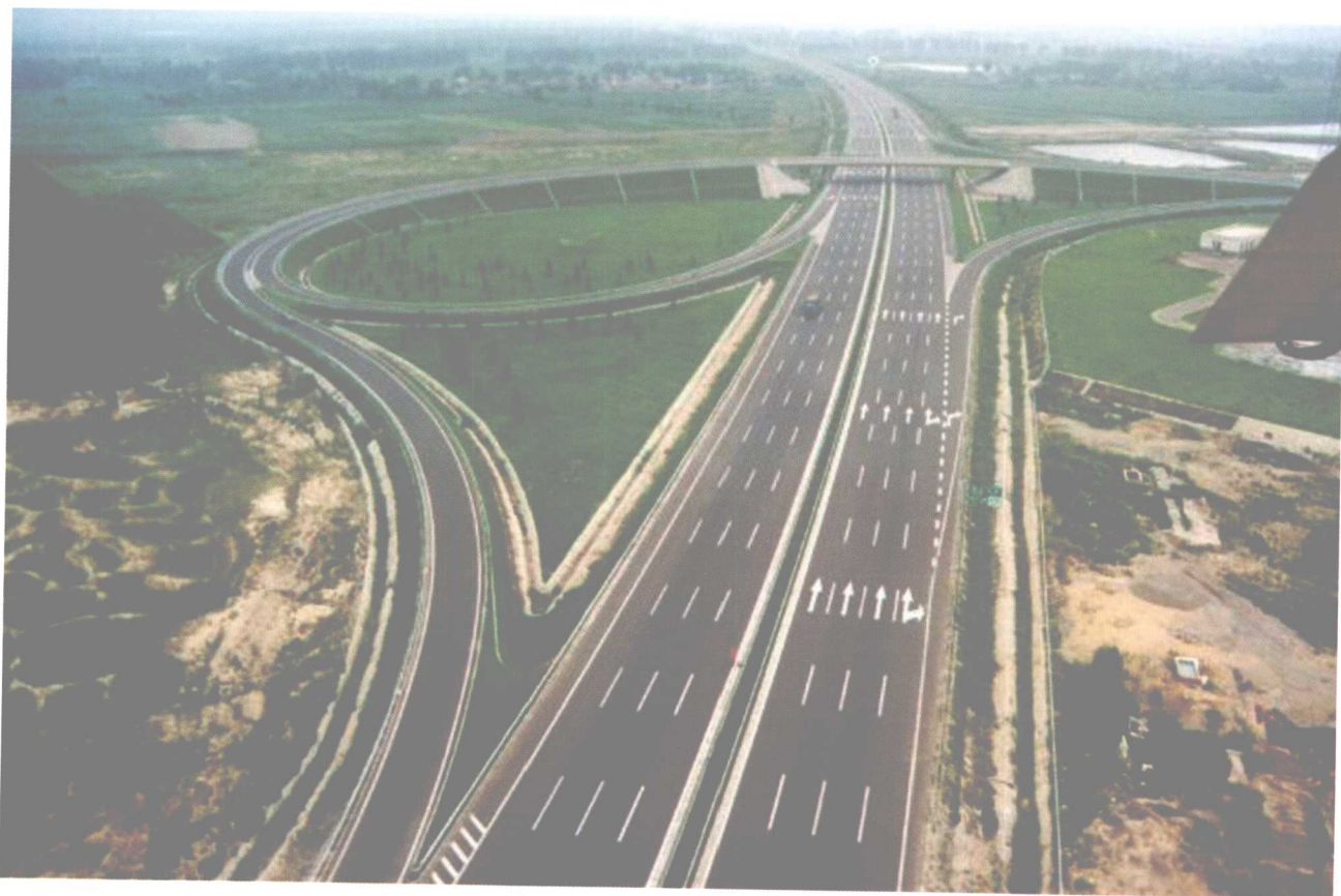
京沈高速公路台安段
