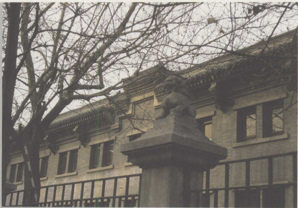
北京辅仁大学校舍旧址
