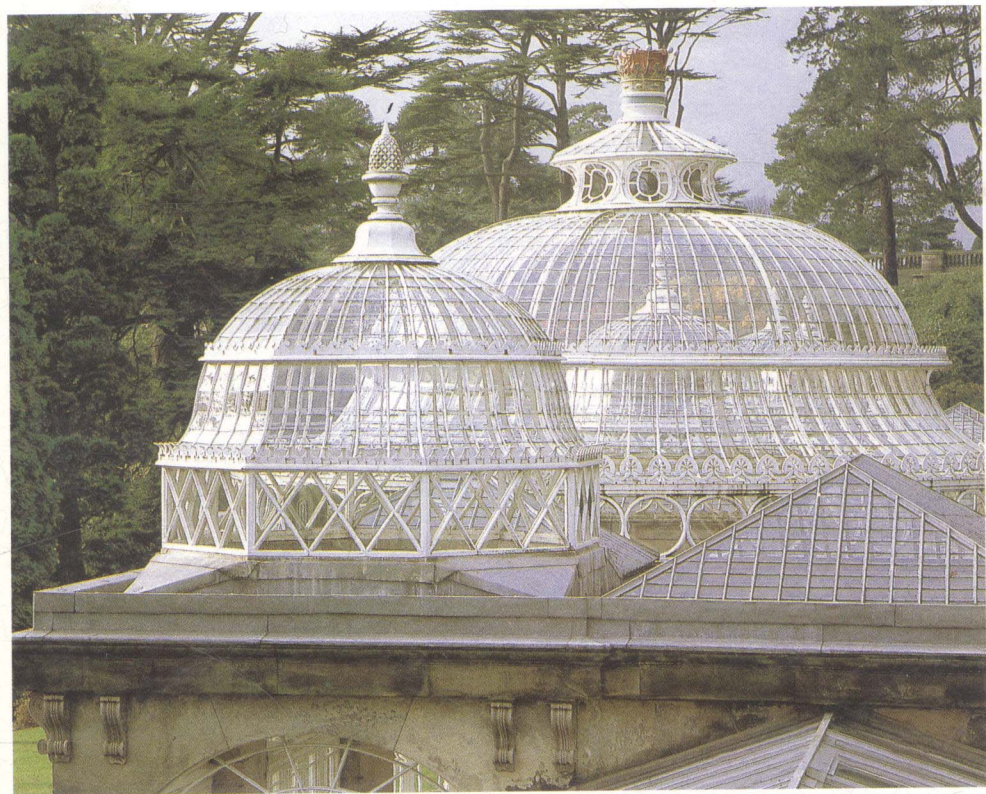
屋顶采用的是铸铁和玻璃条镶嵌保持它的美观，所以不能用木材料代替铸铁
