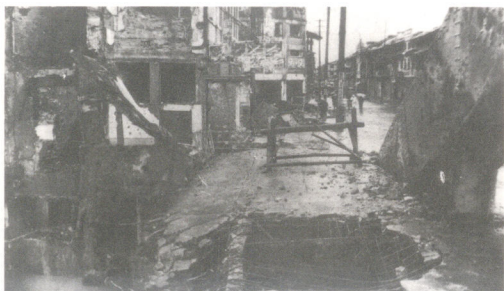
灵桥东端面被炸的一个大洞
