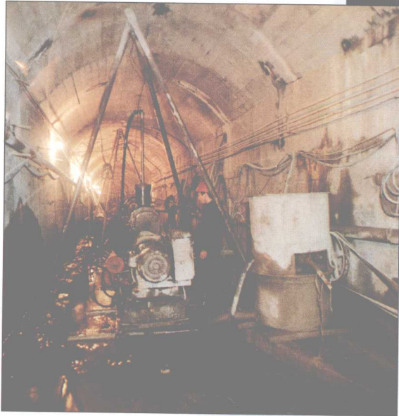
隔河岩工程基础帷幕施工
