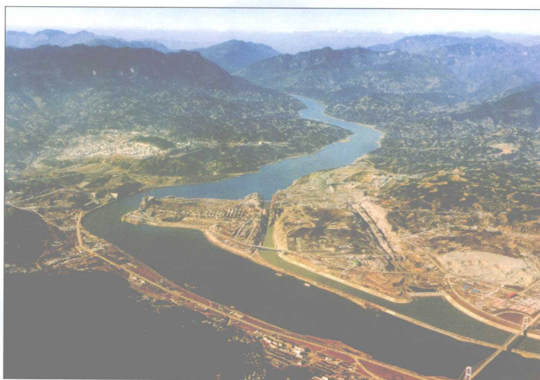
三峡工程施工现场全貌
