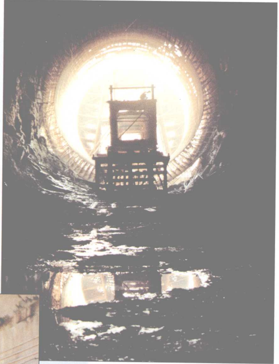
隔河岩水电站引水隧洞施工
