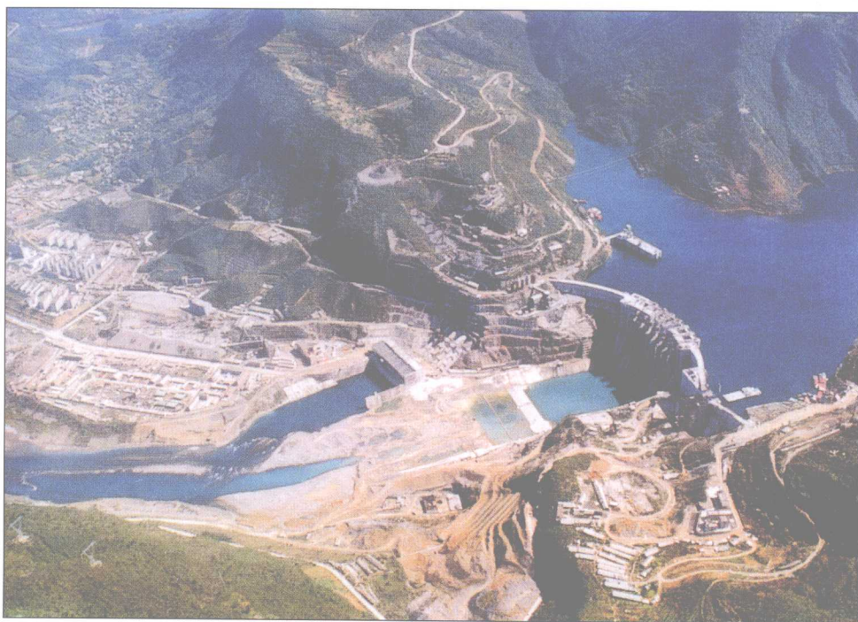
隔河岩水利枢纽全貌
