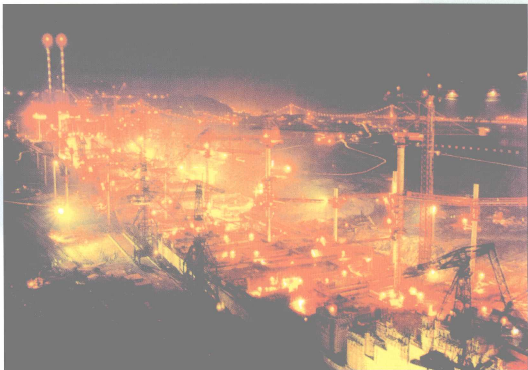
三峡工程施工夜景
