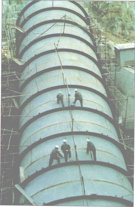
隔河岩水电站压力钢管施工
