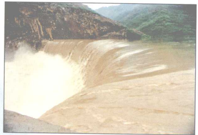
隔河岩工程施工期过水渡汛
