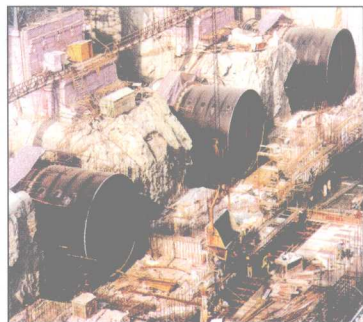
三峡电站压力钢管 安装
