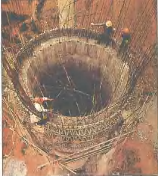
薄壁空心墩施工现场景。
