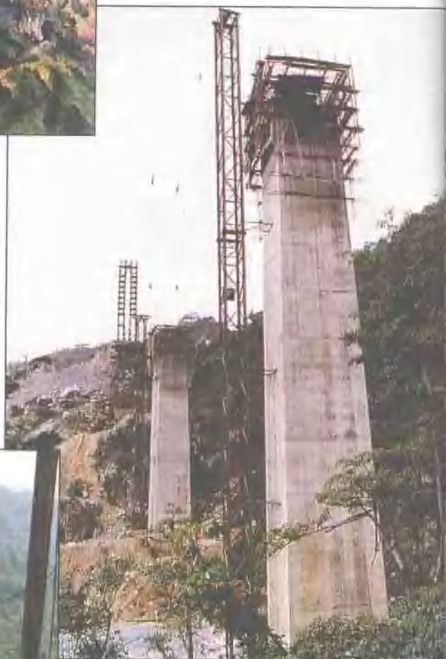
正在建设中的板其二号大桥。
