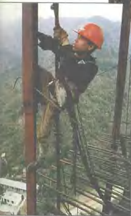
青年工人在高墩上施工。
