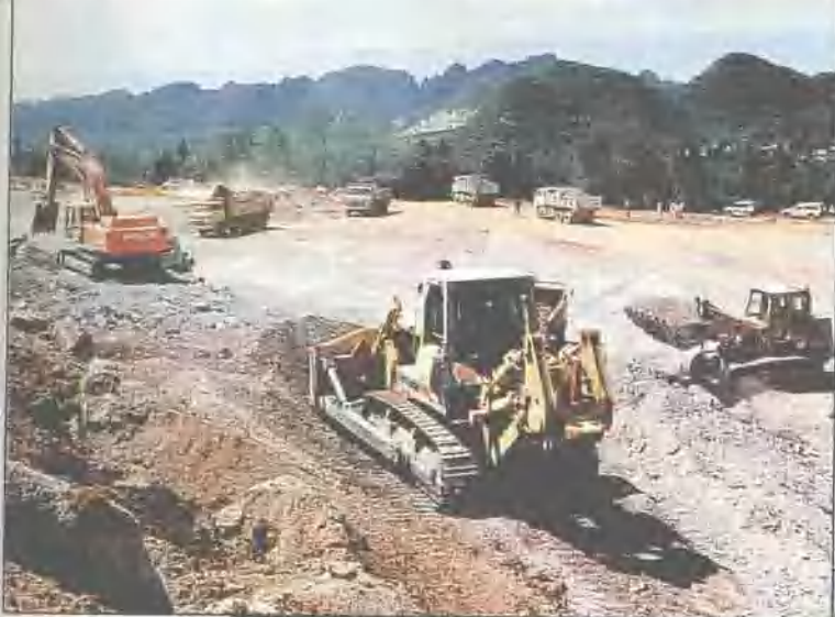
顶效车站机械化施工
