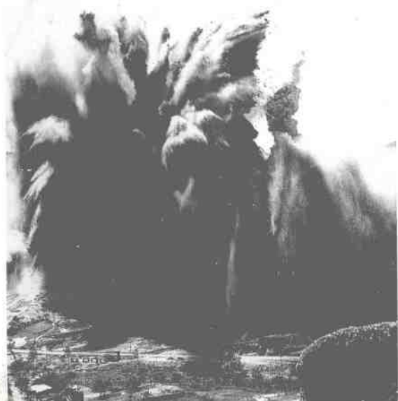
108吨炸药定向爆破
