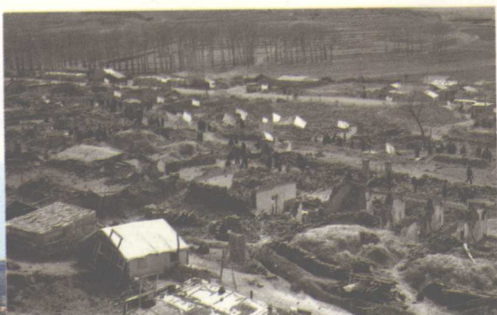
張北地震災區倒塌房屋（一九九八年）
