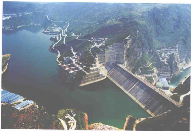
枢纽工程空中俯视
