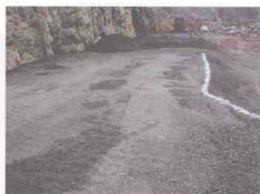
碾压干贫混凝土工作面
