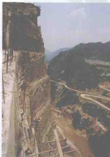
左坝肩高边坡喷锚支护
