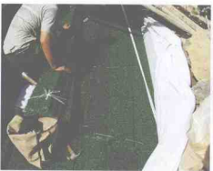
截水沟反滤塑料排水盲材施工
