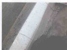
周边缝止水结构的 stainless 保护罩
