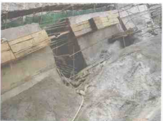
等宽连续窄趾板二序块预留槽
