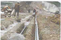
坝内纵向位移计埋设施工
