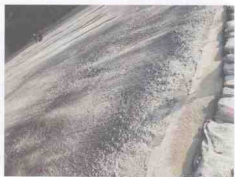
坝面喷乳化沥青
