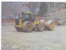
冲击碾压机坝面冲碾压实作业
