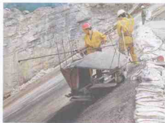
坝面喷乳化沥青作业
