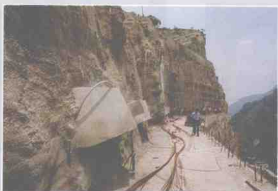
左坝肩高边坡预应力锁口锚索
