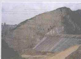
左坝肩高边坡全貌
