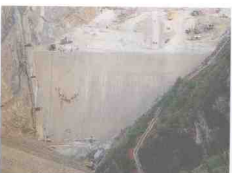
施工中的左岸等宽连续窄趾板
