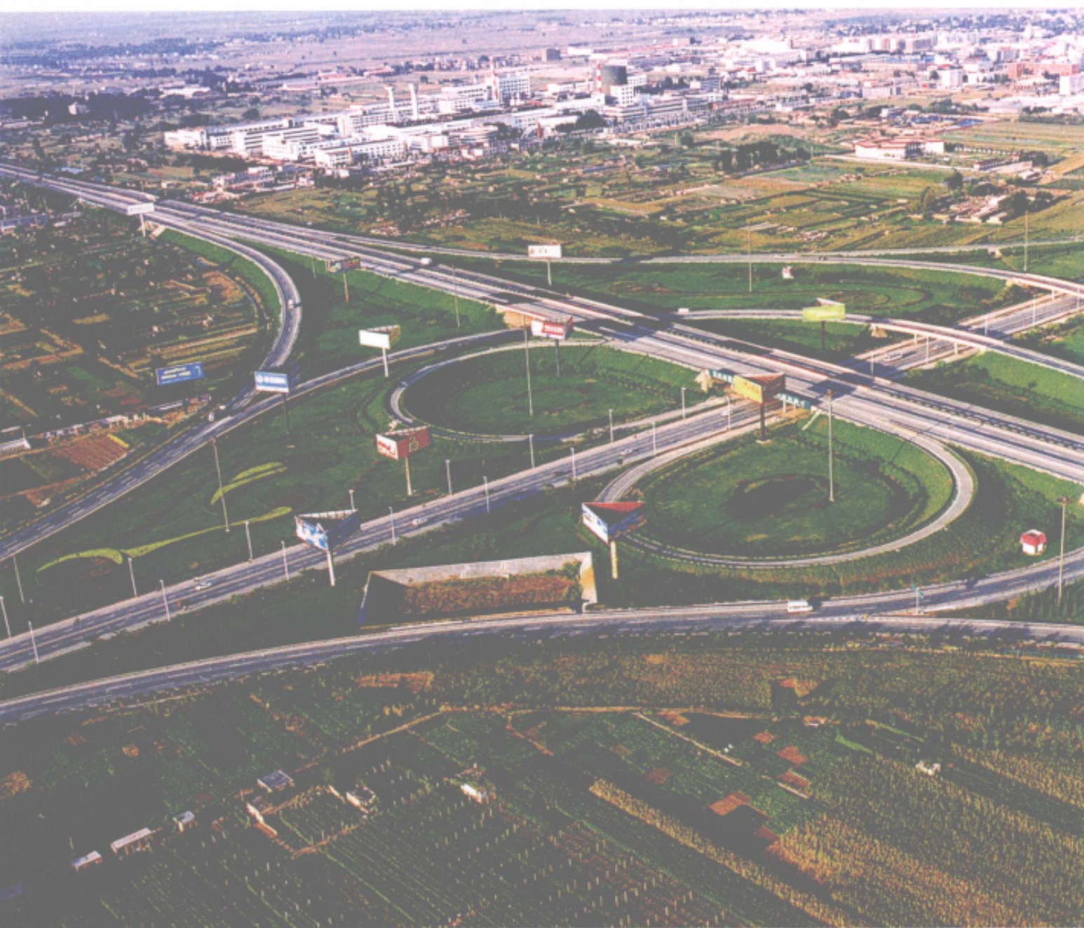
京石高速立交桥
