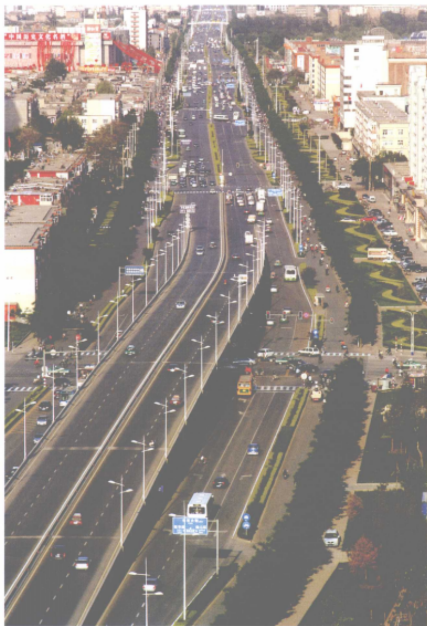
槐安路立交桥
