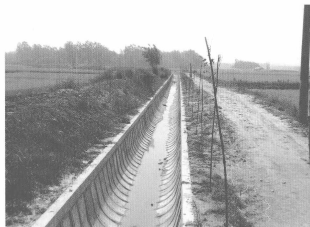
图9 完成后的道路渠系
