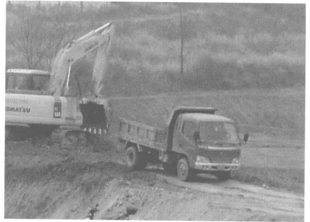
图2 土地平整工程
