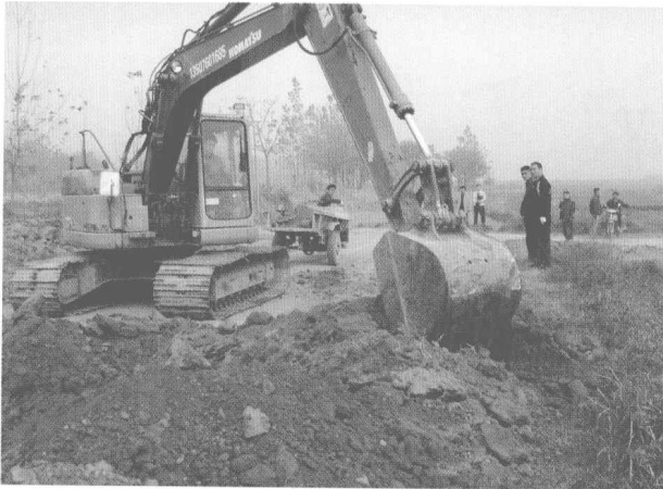
图1 路基开挖工程
