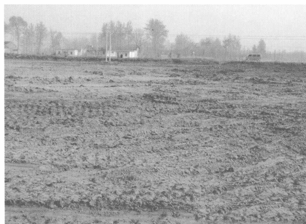
图8 土地平整工程
