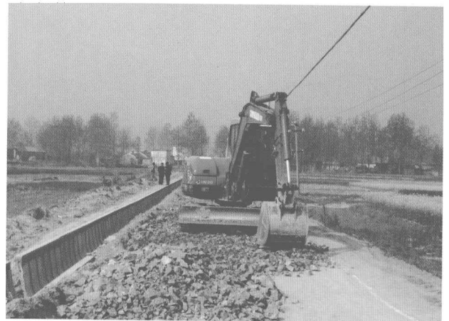
图4 田间道路工程
