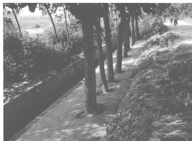
图10 完成后的道路渠系
