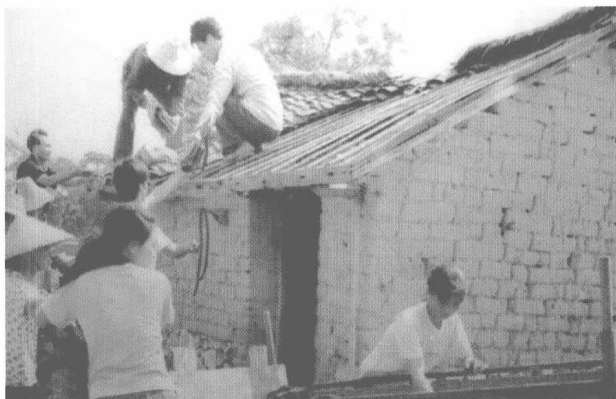
图2 项目整理前农村居民旧宅
