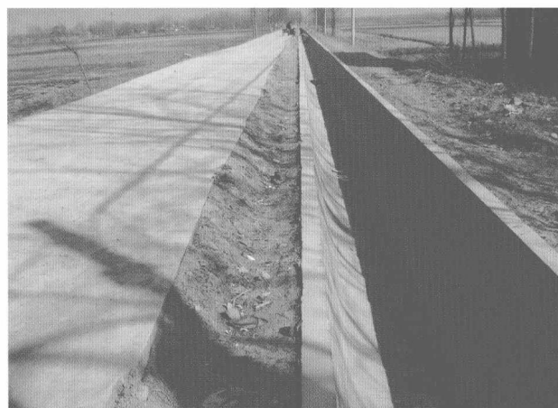
图7 完成后的道路渠系
