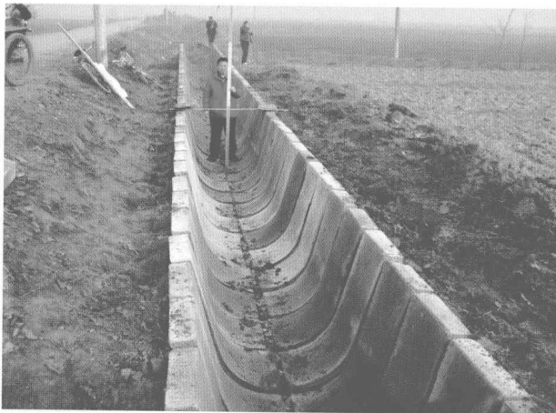
图3 U型渠工程
