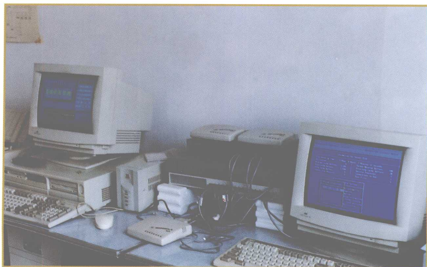
市烟草专卖局 (分公司) 网络中心机房一角
