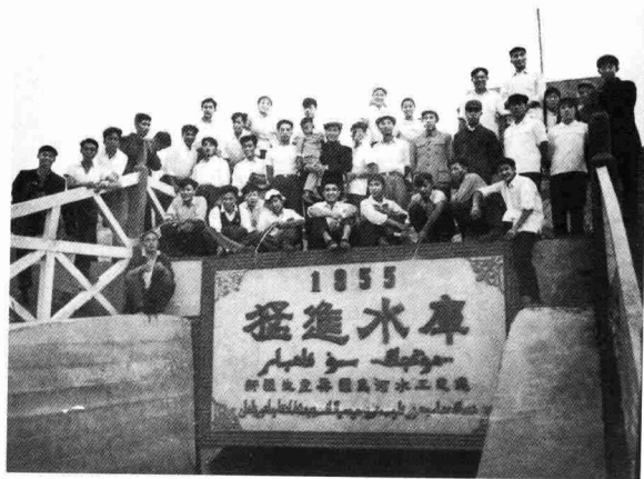
1955 年农六师猛进水库 水闸完工
