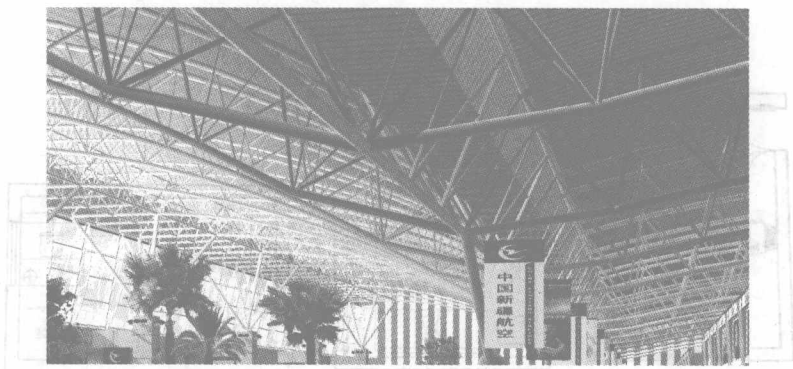
图 1-3 梁、柱结构所占的室内空间
