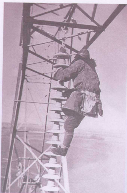
1942年，220千伏东连线瓷瓶安装施工
