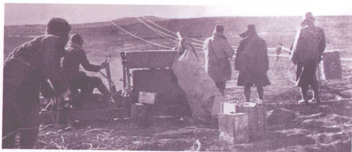
1941年12月，220千伏东连线施工现场
