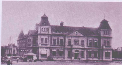
1909年，南满洲铁道株式会社电气作业所事务所
