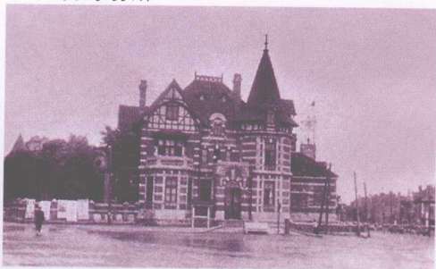
1908年，南满洲铁道株式会社电气作业所事务所
