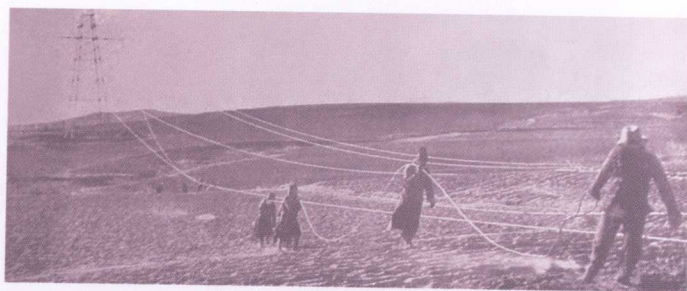
1941年12月，220千伏东连线架线施工
