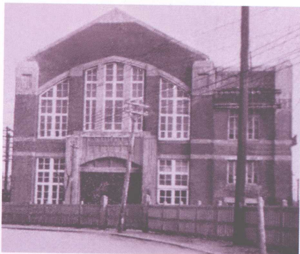
1923年，敷岛广场变电所
