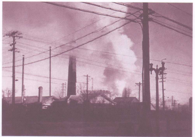
1935 年，大连市区工业区配电线路
