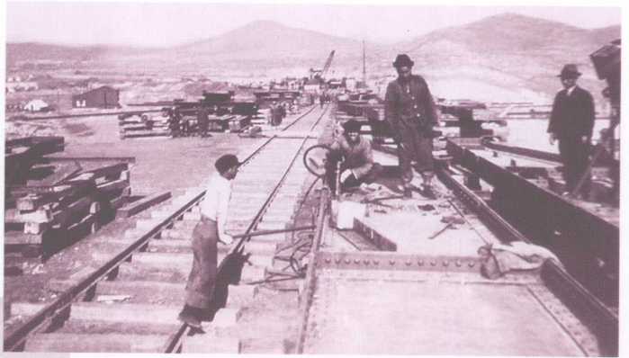
南满洲铁道株式会社时期，建设中的甘井子有轨电车
