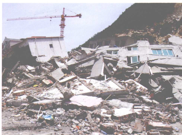
图 2.5 北川县城某几栋砌体结构房屋倒塌
