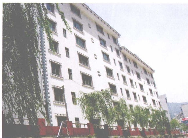
图 2.6 北川县城某6层砌体结构房屋破坏较轻
