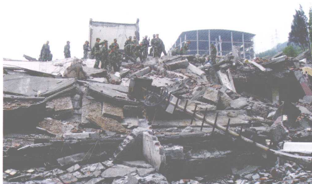
图 2.7 汶川县漩口镇某底部框架房屋倒塌
