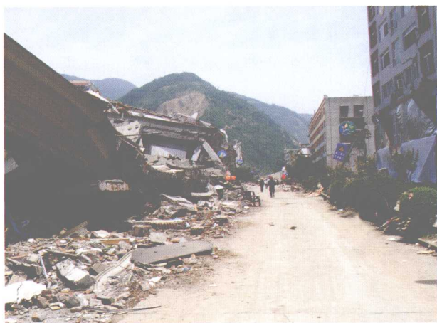
图 2.2 北川县城某街道两侧砌体结构房屋倒塌和严重破坏 (一侧底部框架房屋和砌体结构完全倒塌,另一侧破坏严重)
