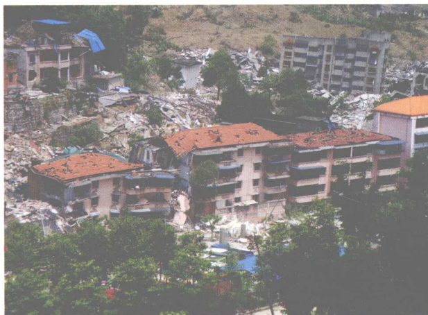
图 2.3 北川县城砌体结构房屋倒塌或局部倒塌
