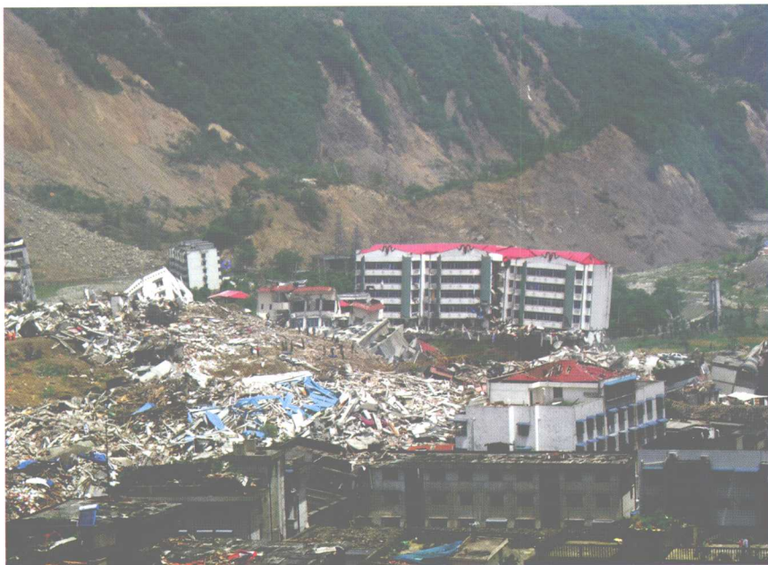
图 2.1 北川县城砌体房屋 倒塌严重
