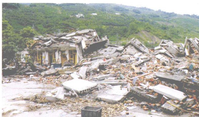
图 2.8 汶川县漩口镇某砌体结构房屋倒塌
