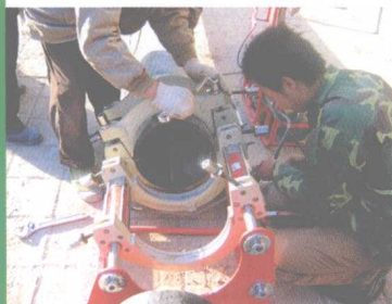
城市供水管网改造
