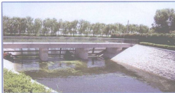
上庄水库水循环工程
