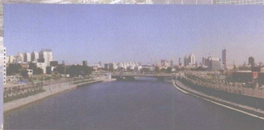
海河综合改造 提升城市竞争力
