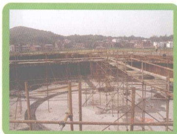
污水处理厂1#沉淀池施工现场
