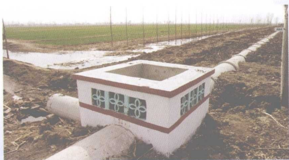
增加投入建设大口径混凝土管节水工程
