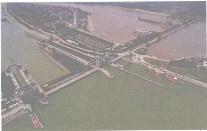
葛洲坝水利枢纽工程全貌
