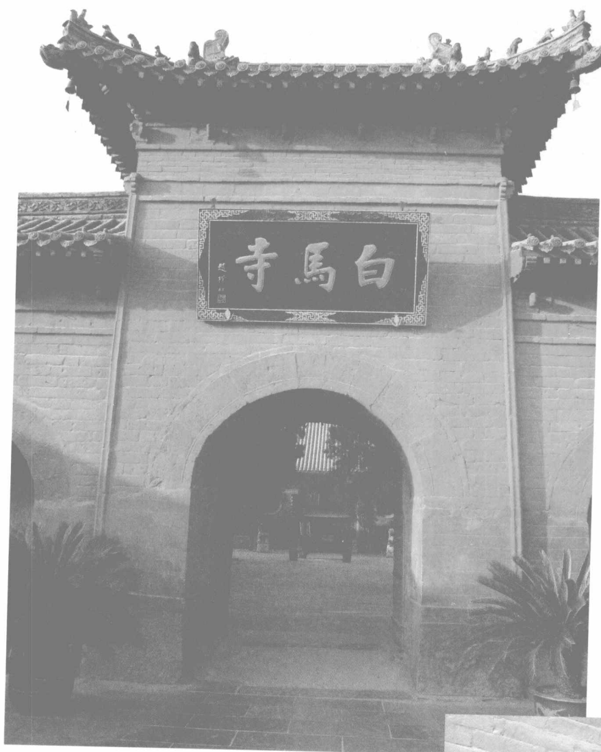
1. 洛阳白马寺山门中门洞的扇形黄肠石券顶
