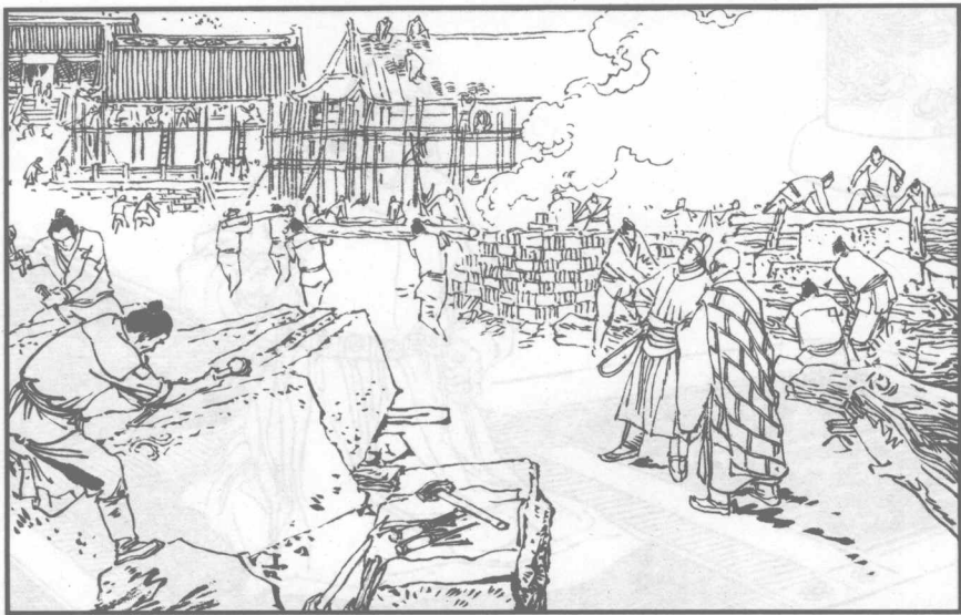
3 并且大兴土木，用了数万民工，兴建寿安山寺。为了铸造寺中佛像，赐铜五十万斤。
