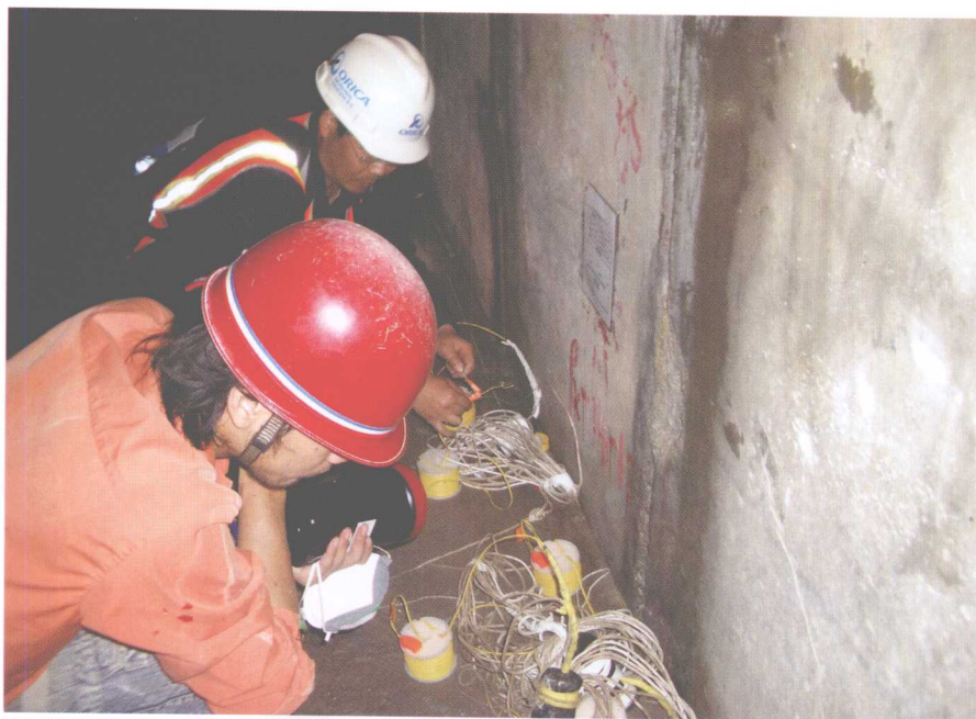
三峡工程RCC围堰装药施工现场
