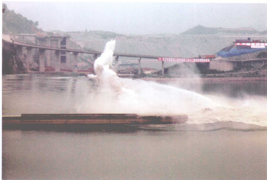
三峡工程RCC围堰爆破瞬间
