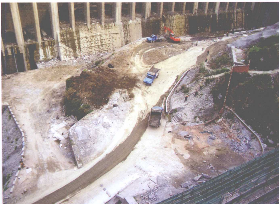
三峡工程RCC围堰装药施工现场
