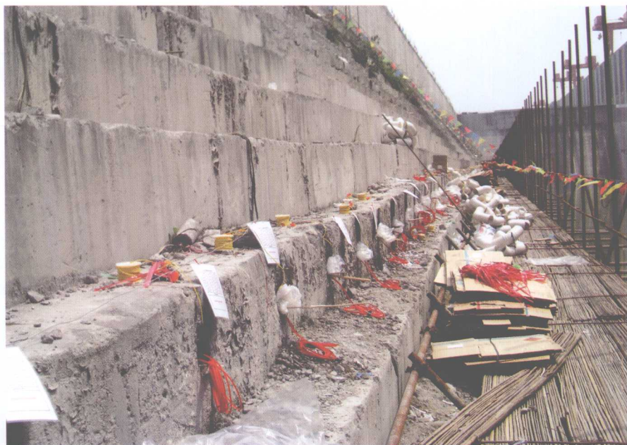
三峡工程RCC围堰装药施工现场
