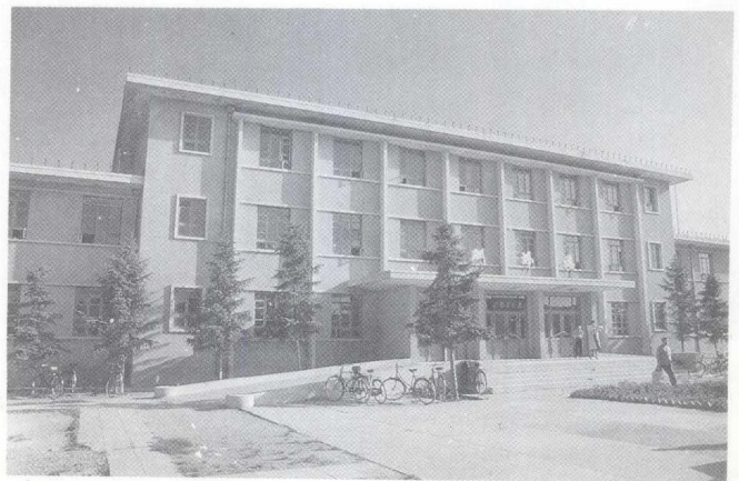
张北县医院门诊楼
