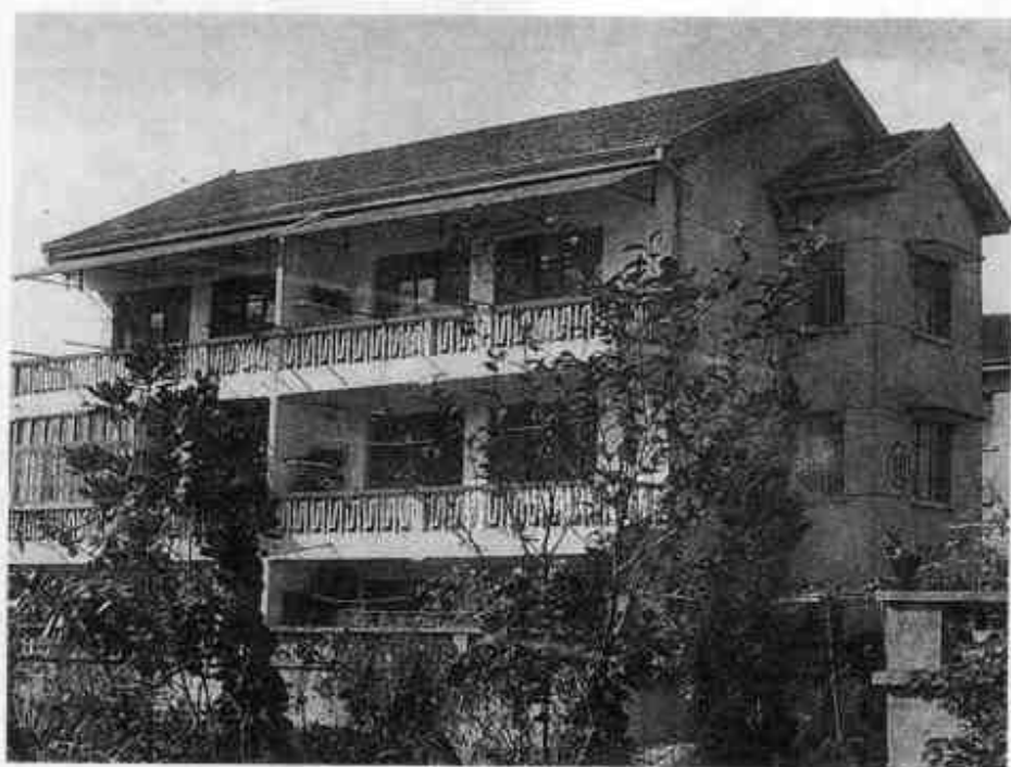
易家桥教工宿舍区一角
