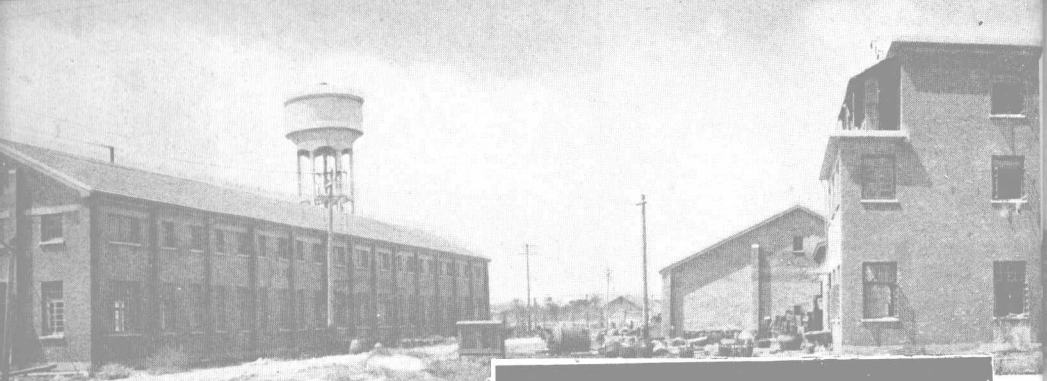
安利化工厂厂房外景
