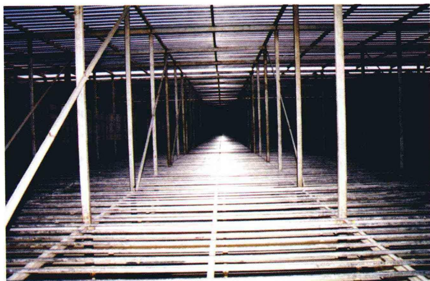
悬挂弹性立体填料的 304 不锈钢填料支架
