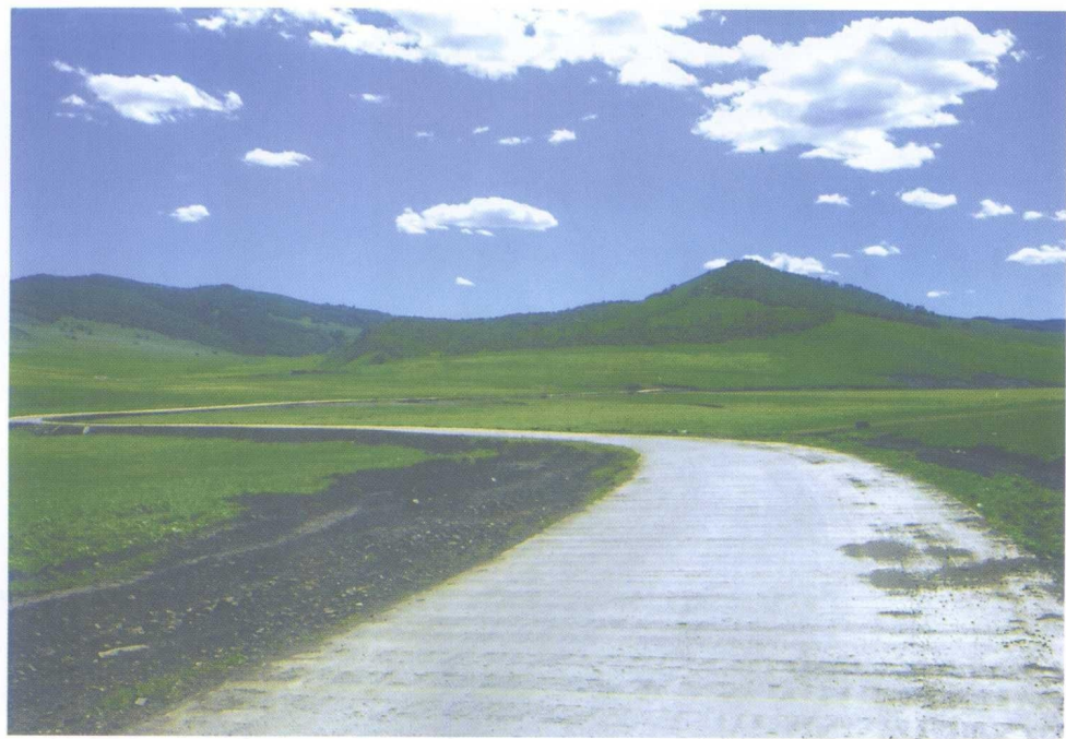
伸向草原深处的水泥路
