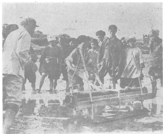
农民用自己制造的插秧机，試驗插秧。
