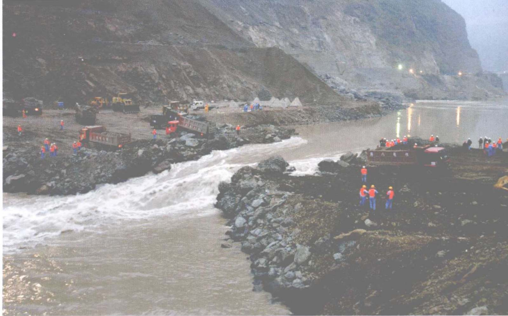
金沙江溪洛渡水电站工程截流下龙口
