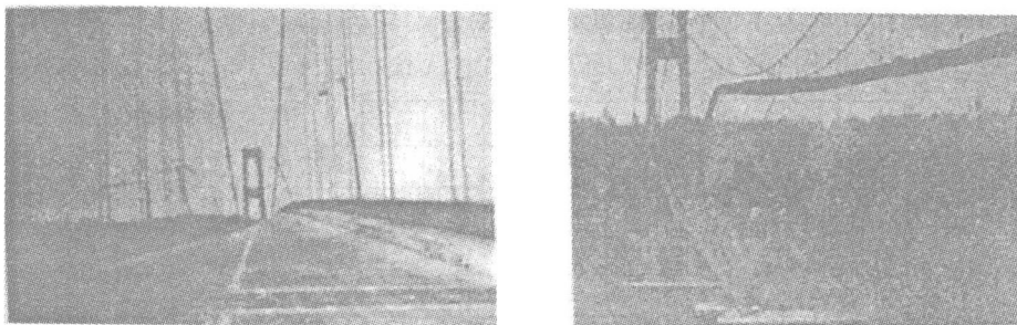
图 1.5 塔科马桥风致共振破坏
