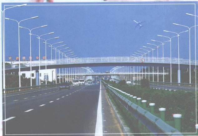
机场高速公路
