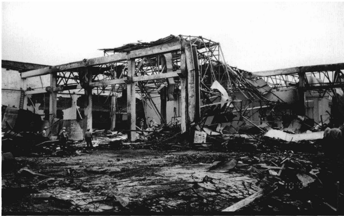
图10 雷击造成化工厂爆炸的事故现场
