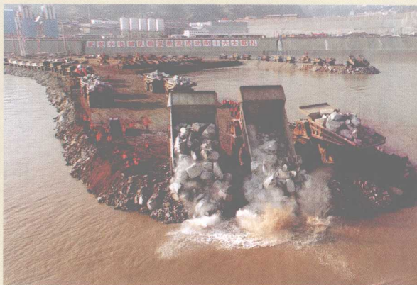
水电部队承担导流明渠截流任务
