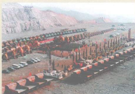
水电部队抽调精良设备建设三峡永久船闸
