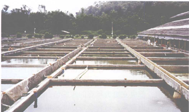
图13 室外水泥养殖池
