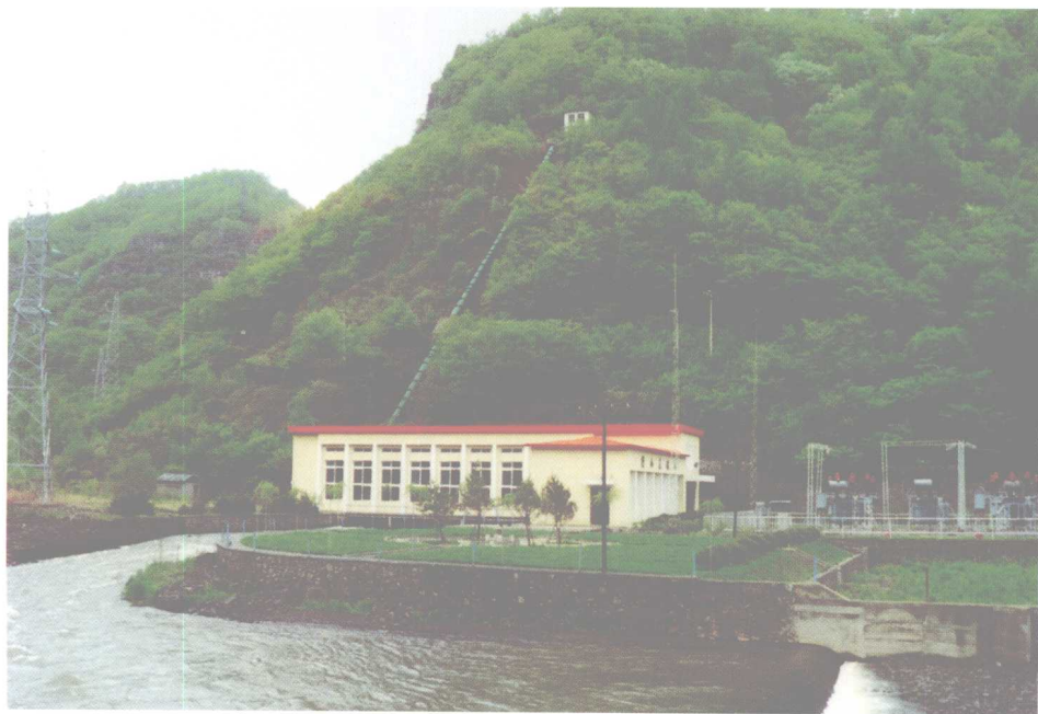
水电产业快速发展，总装机达到5.1万千瓦，年发电量达到1.6亿千瓦时，成为县城主导产业。 图为双山发电厂。
