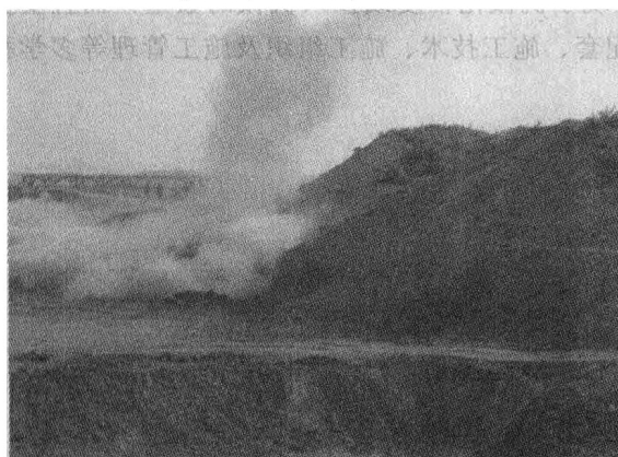
图 1.6 路基爆破施工
