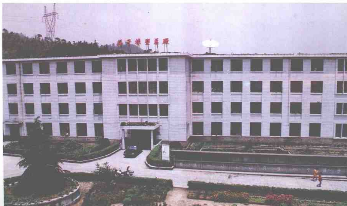
总厂办公大楼
