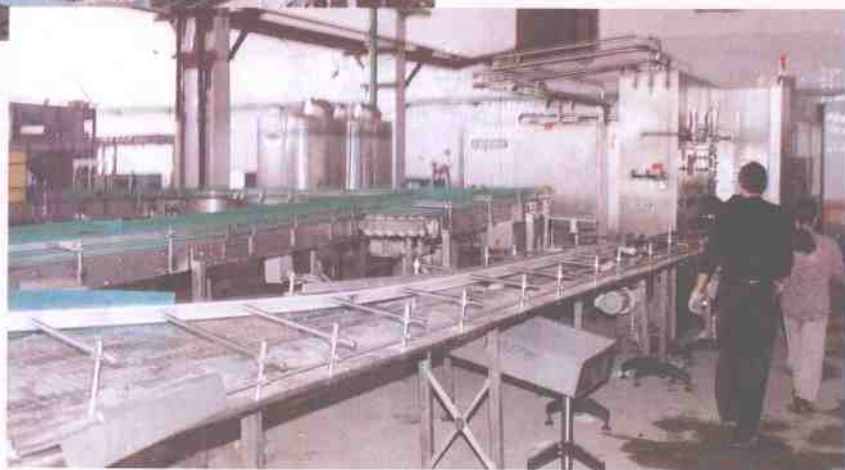
从西德引进的啤酒 灌装线正在安装中
