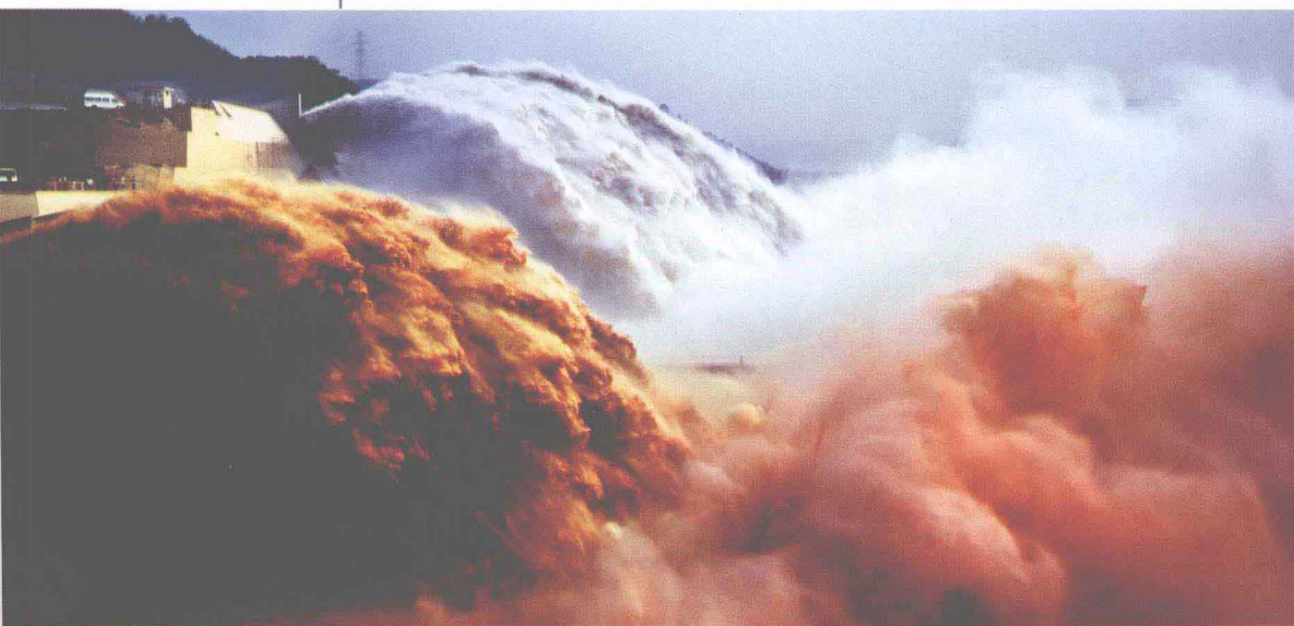
黄河小浪底水利 枢纽调水调沙的壮观 场景
