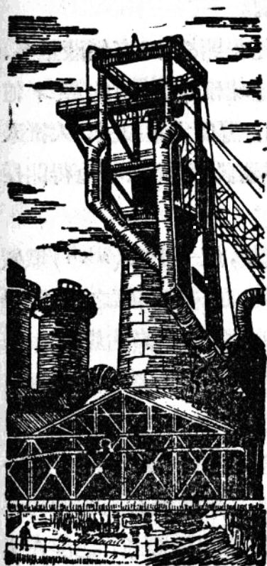
圖一 煉鐵爐（左下是熱風爐）
