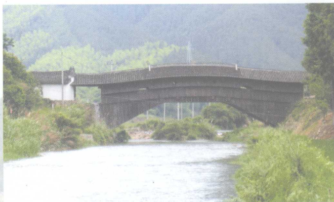
▲ 竹口溪古廊桥——后坑桥
