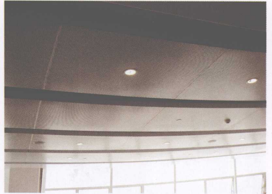
彩图 26 金属板悬吊式顶棚
