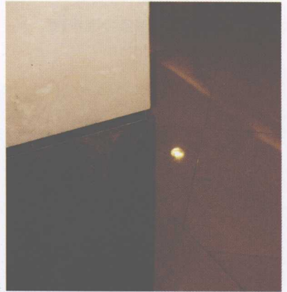
彩图 28 墙面不同石材交接处凹缝构造
