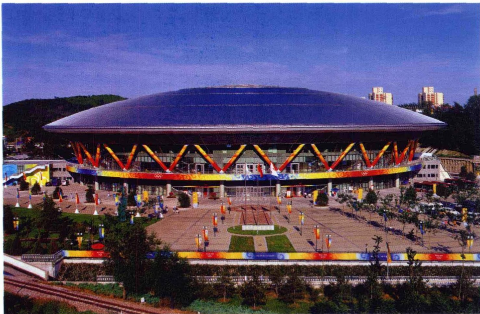
图片 1 2008 年北京奥运会老山自行车馆全貌
