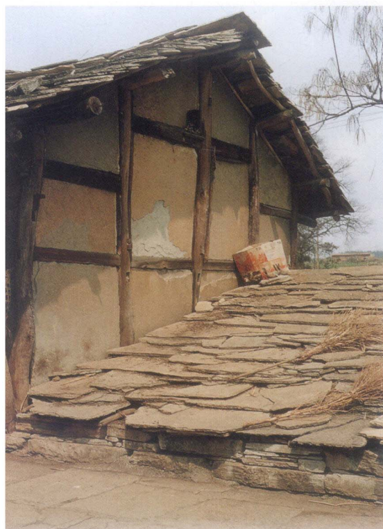
木架穿斗结构、石板作壁的石板房。
