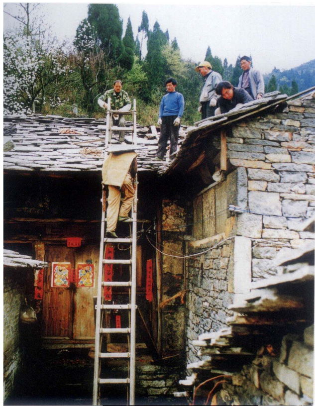
石板房顶盖维修。
