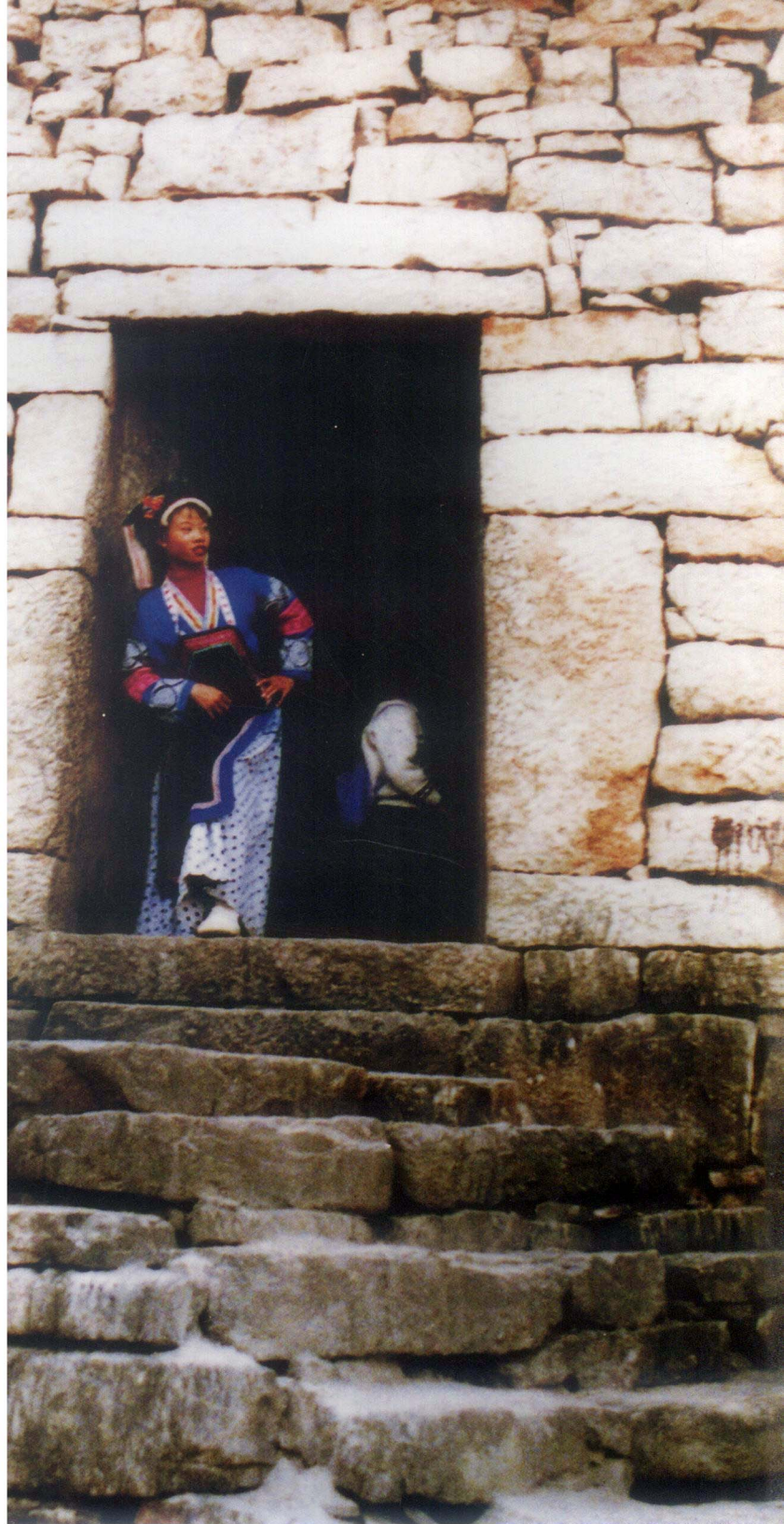
全石结构的门洞。（关岭布依族苗族自治县滑石哨布依族民居）
