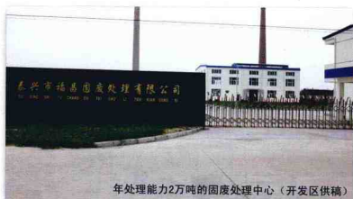
年处理能力2万吨的固废处理中心(开发区供稿)
