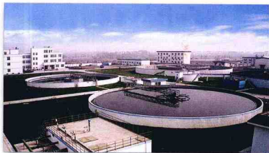
总投资1亿元、一期日处理能力3万吨 (设计能力10万吨)的污水处理厂 (开发区供稿)
