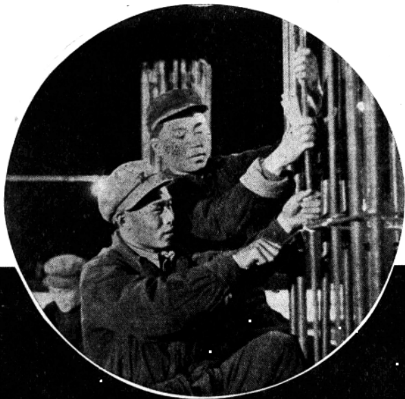
夜班工人正在紮製 鋼筋支柱。
