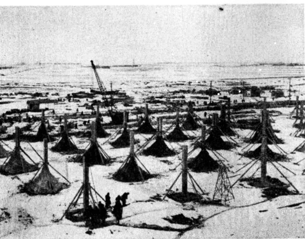
上圖爲工人們用蘇聯先進經驗電熱法澆灌混凝土。
