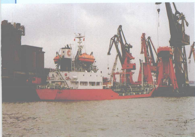
上海溶剂厂万吨级深水码头
