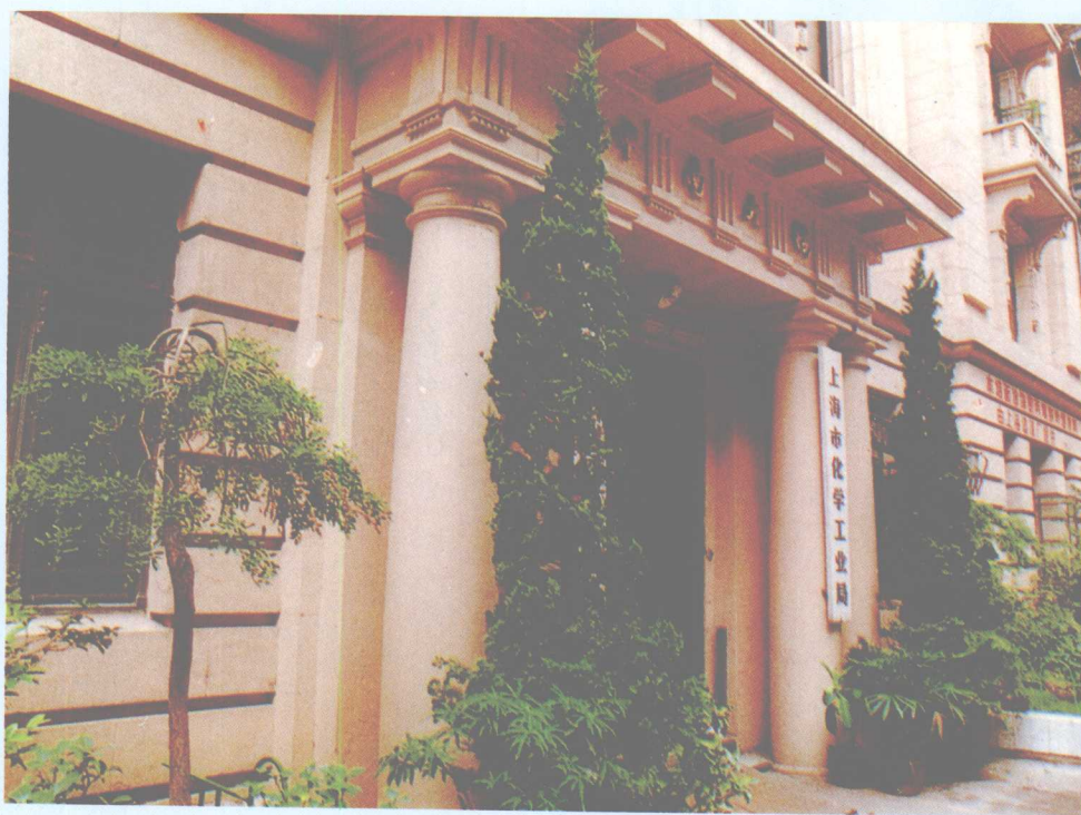
上海市化学工业局大楼
