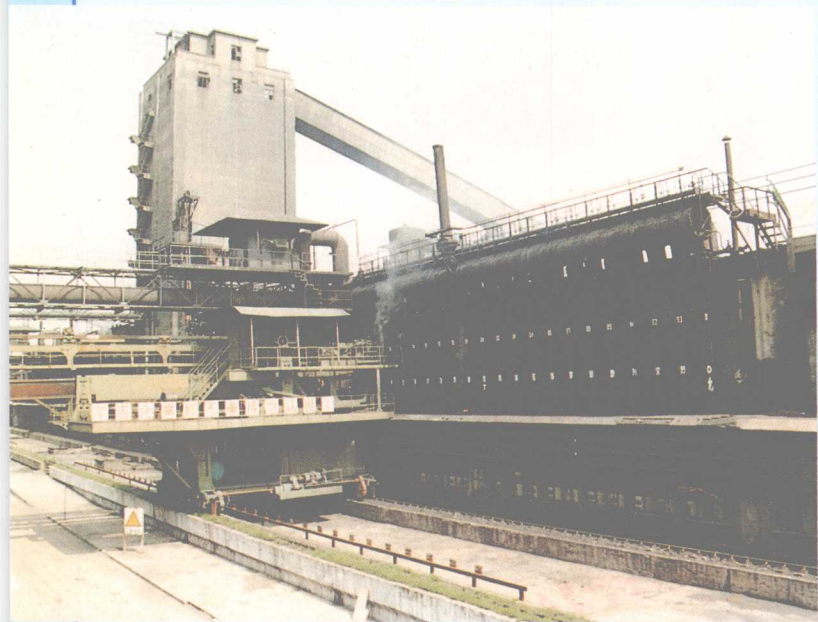
上海焦化总厂焦炉
