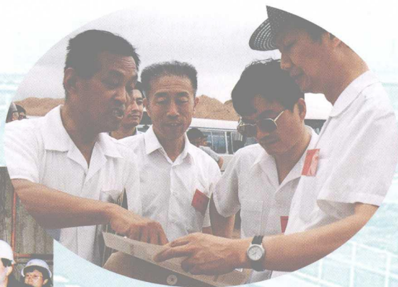
20世纪80年代，沈大高速公路市分指挥部副指挥、市交通局长邵德贵在施工现场向参加全国高等级公路建设经验交通现场会议的代表汇报大连段工程建设情况
