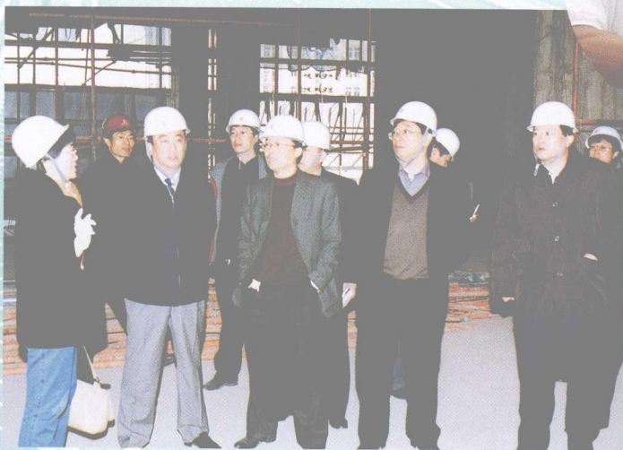
2004年4月，大连市交通口岸管理局局长汪集刚，副局长于长敏、梁旭山等听取市航运交易市场大楼建设情况
