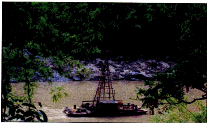
澜沧江糯扎渡电站坝址钻探
